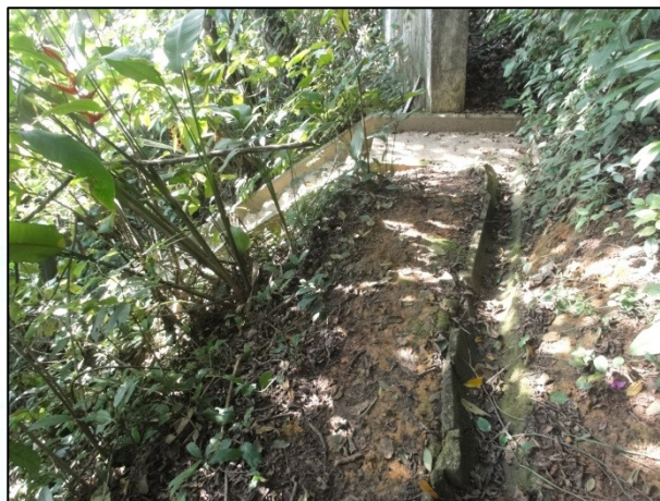
Foto 12 – Canaleta de drenagem em 2019. Notar a menor presença de folhas e galhos.
