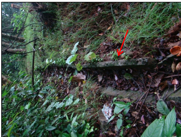
Foto 11 – Canaleta de drenagem em 2012. Notar a presença de folhas e galhos, indicativo de falta de limpeza.
