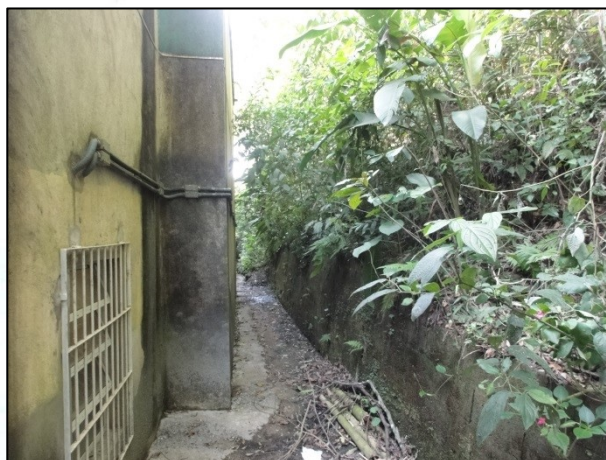
Foto 16 – Detalhe da proximidade da encosta com a edificação. Notar a existência de uma janela bem próxima à encosta, que em caso de queda de blocos seria facilmente atingida.
