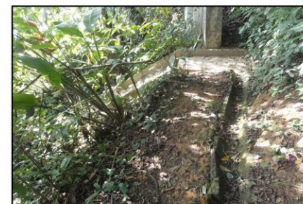
Canaleta de drenagem em 2019. Notar a presença menos intensa de folhas e galhos.
