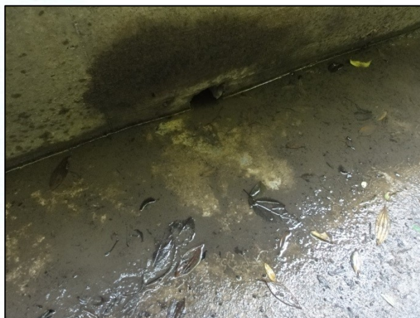
Foto 14 – Detalhe do furo existente para a saída d'água atrás do muro. Notar o acúmulo de água atrás do muro.
