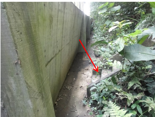
Foto 7 - Vista da estrutura de contenção. Notar os contrafortes e drenagem superficial desaguando atrás da estrutura.
