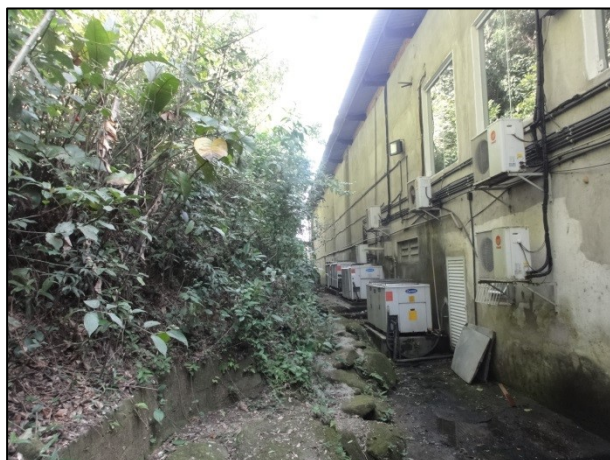
Foto 15 – Vista da encosta nos fundos do Palácio das Artes. Notar a falta de estrutura de contenção nessa área.
