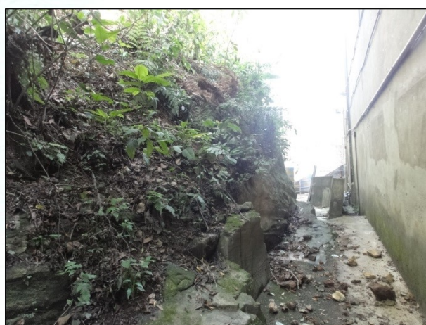
Foto 18 – Deslocamento recente de pequenos blocos atrás da edificação.
