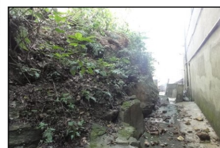
Deslocamento recente de pequenos blocos atrás da edificação.
