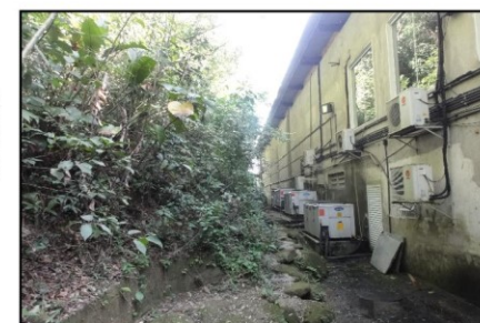
Vista da encosta atrás do Palácio das Artes, onde não há estrutura de contenção.
