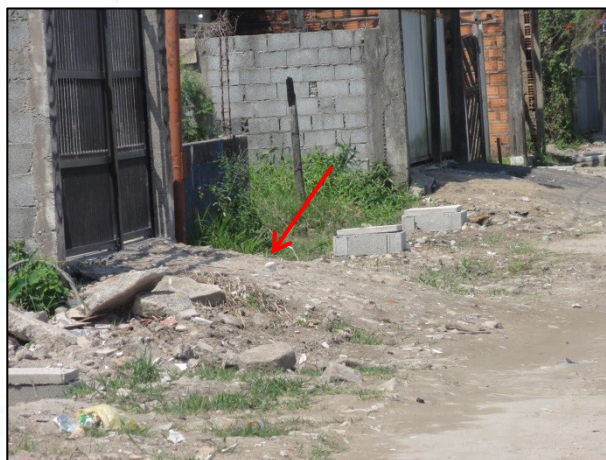
Foto 30 - Detalhe do alteamento das moradias (seta vermelha) devido às frequentes inundações no local.
