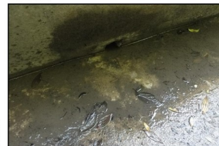
Detalhe do furo existente para a saída d'água atrás do muro. Notar como a água se acumula atrás do muro.
