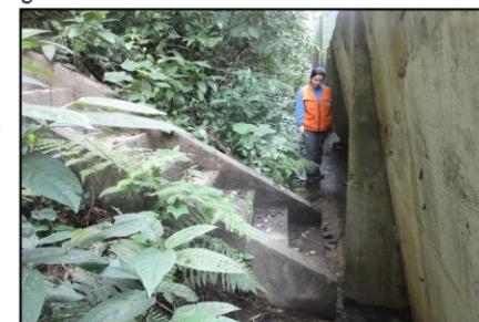
Vista da escada d'água desaguando atrás da estrutura de contenção. Notar a inexistência de condução apropriada na destinação das águas providas da encosta.
