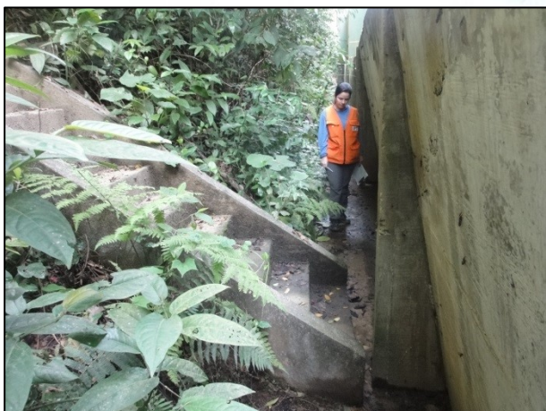
Foto 13 – Vista da escada d'água desaguando atrás da estrutura de contenção. Notar a ausência de condução apropriada na destinação das águas providas da encosta.
