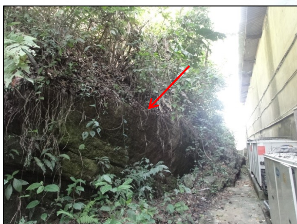
Foto 17 – Detalhe de um grande bloco existente próximo à edificação (seta vermelha). Indicativo de queda de blocos no local.
