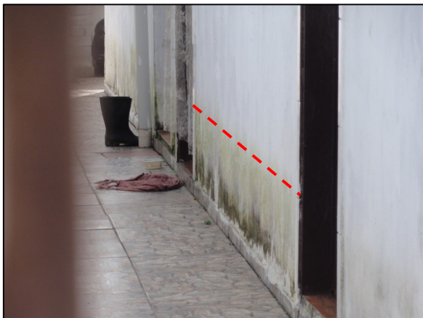
Foto 21 – Vista da marca d'água na parede da moradia na Vila Sônia (linha tracejada).
